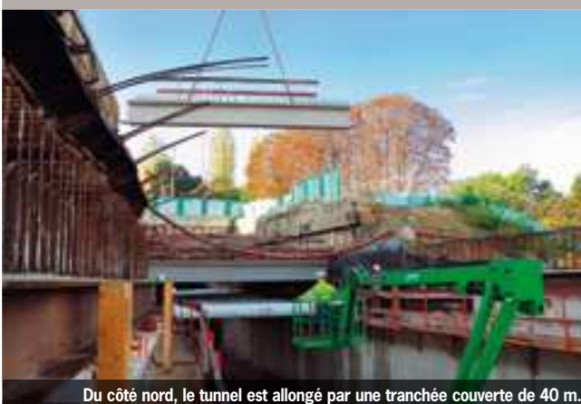
Du côté nord, le tunnel est allongé par une tranchée couverte de 40 m.
